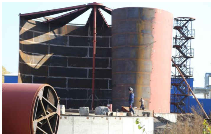
Рисунок 6 – Возведение резервуара рулонным методом
