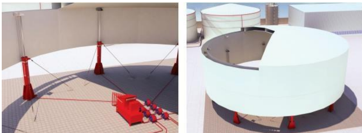
Рисунок 5 – Возведение резервуара методом подращивания
