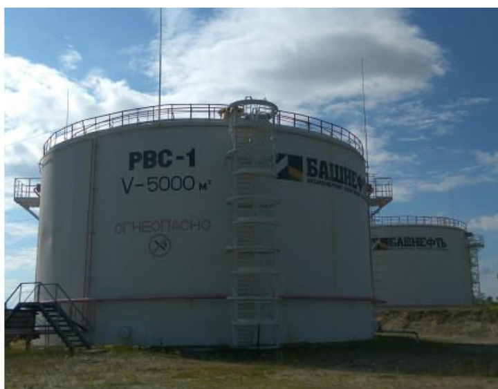
Рисунок 1 – Внешний вид резервуара РВС-5000
