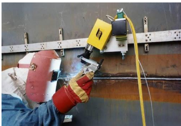
Рисунок 10 – Сварка горизонтального шва резервуара с использованием системы RailTrack 1000 (ESAB)
