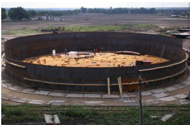
Рисунок 4 – Возведение резервуара методом наращивания
