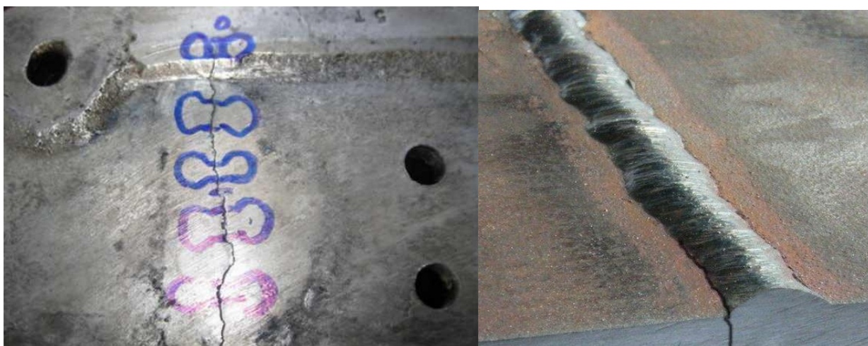
Рисунок 3 – Горячие трещины при сварке
