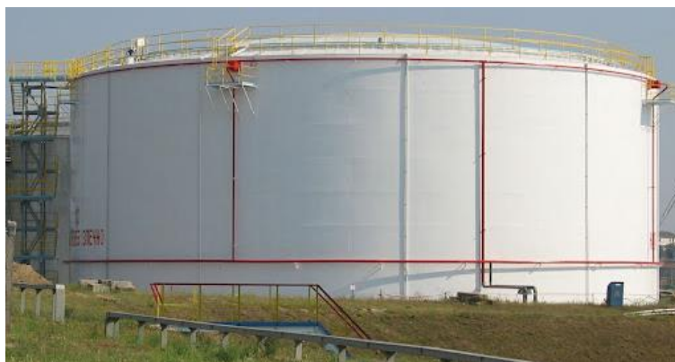
Рисунок 1 – Внешний вид резервуара РВСП-20000
