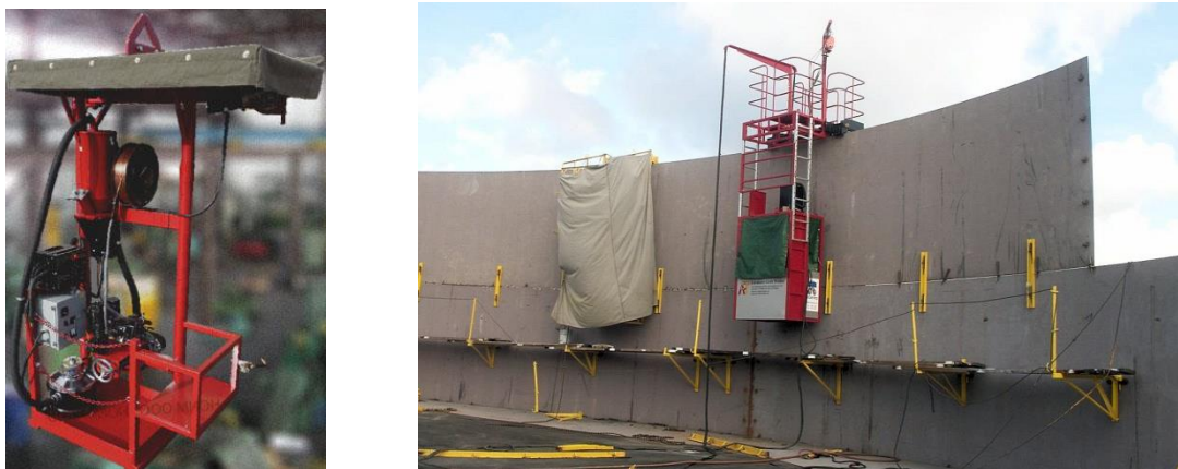
Рисунок 10 – Сварка горизонтального стыка с использованием установки AGW-I
