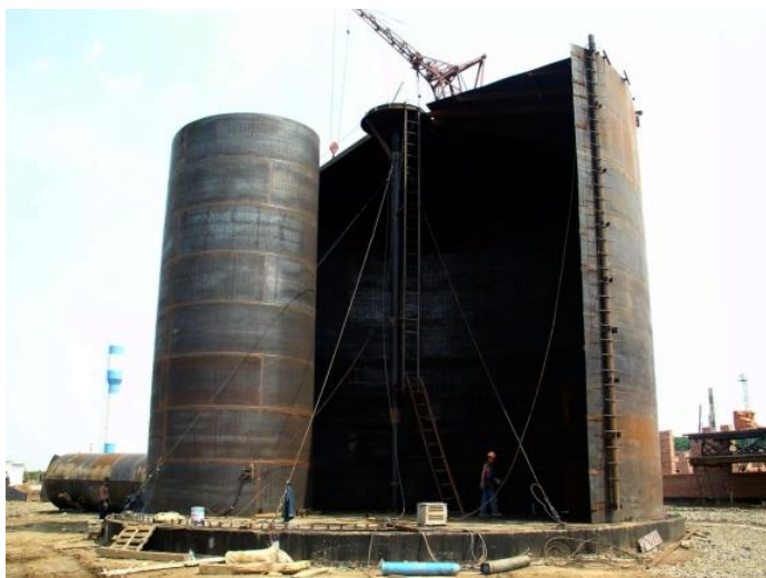
Рисунок 5 – Возведение вертикального стального резервуара рулонным методом
