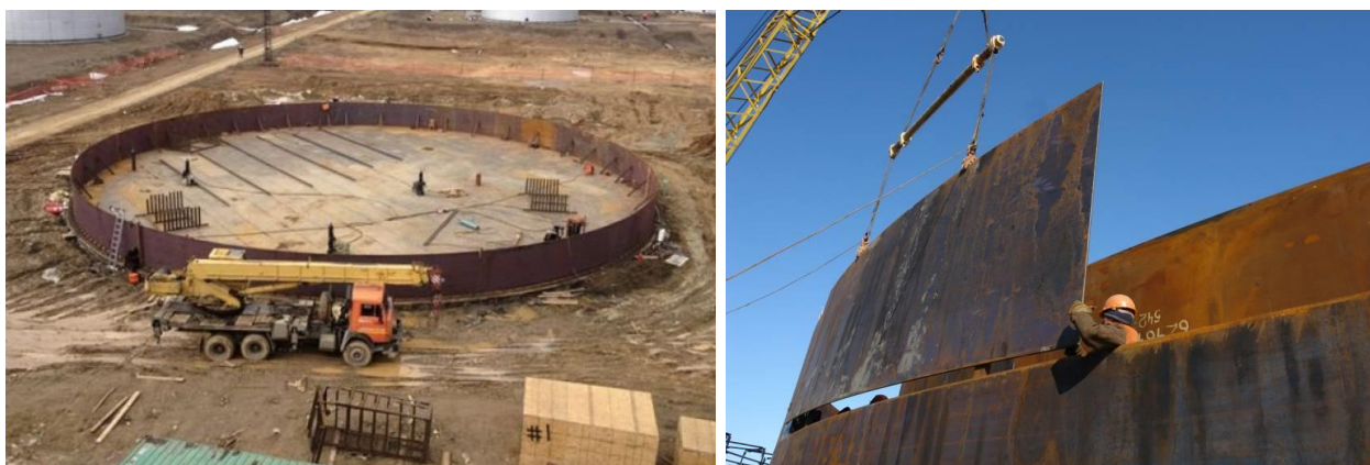
Рисунок 3 – Возведение резервуара полистовым методом (метод наращивания)
