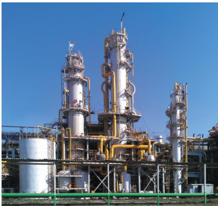
Рисунок 2 – Теплообменные колонны для нагревания циклогексана
