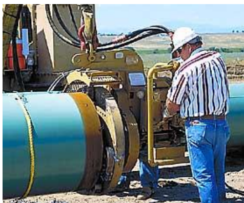
Рисунок 8 – Подготовка кромок труб с использованием станка PFM 3456
