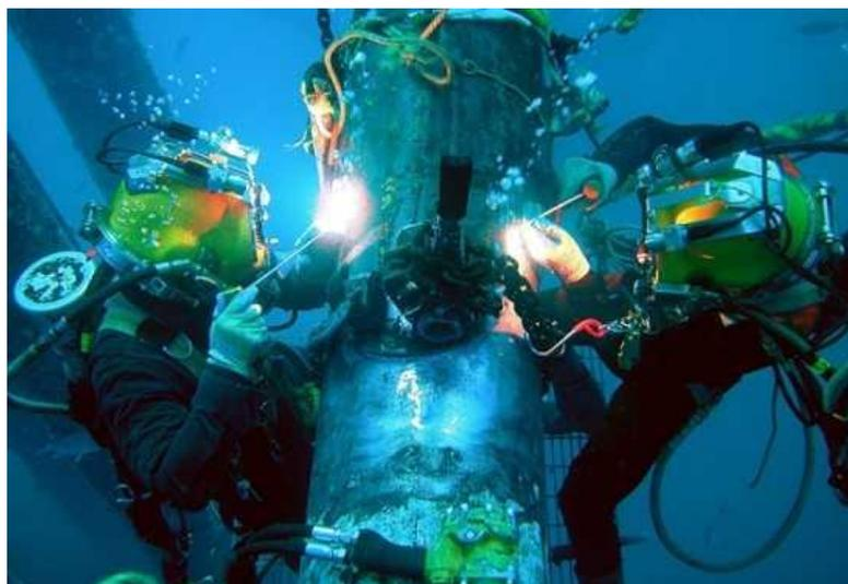
Рисунок 2 – Подводная сварка трубопровода
