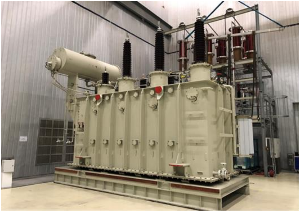
Рисунок 5 – Трансформатор ТДТН-40000/110-У1 производства ООО «Сименс Трансформаторы» г. Воронеж.
