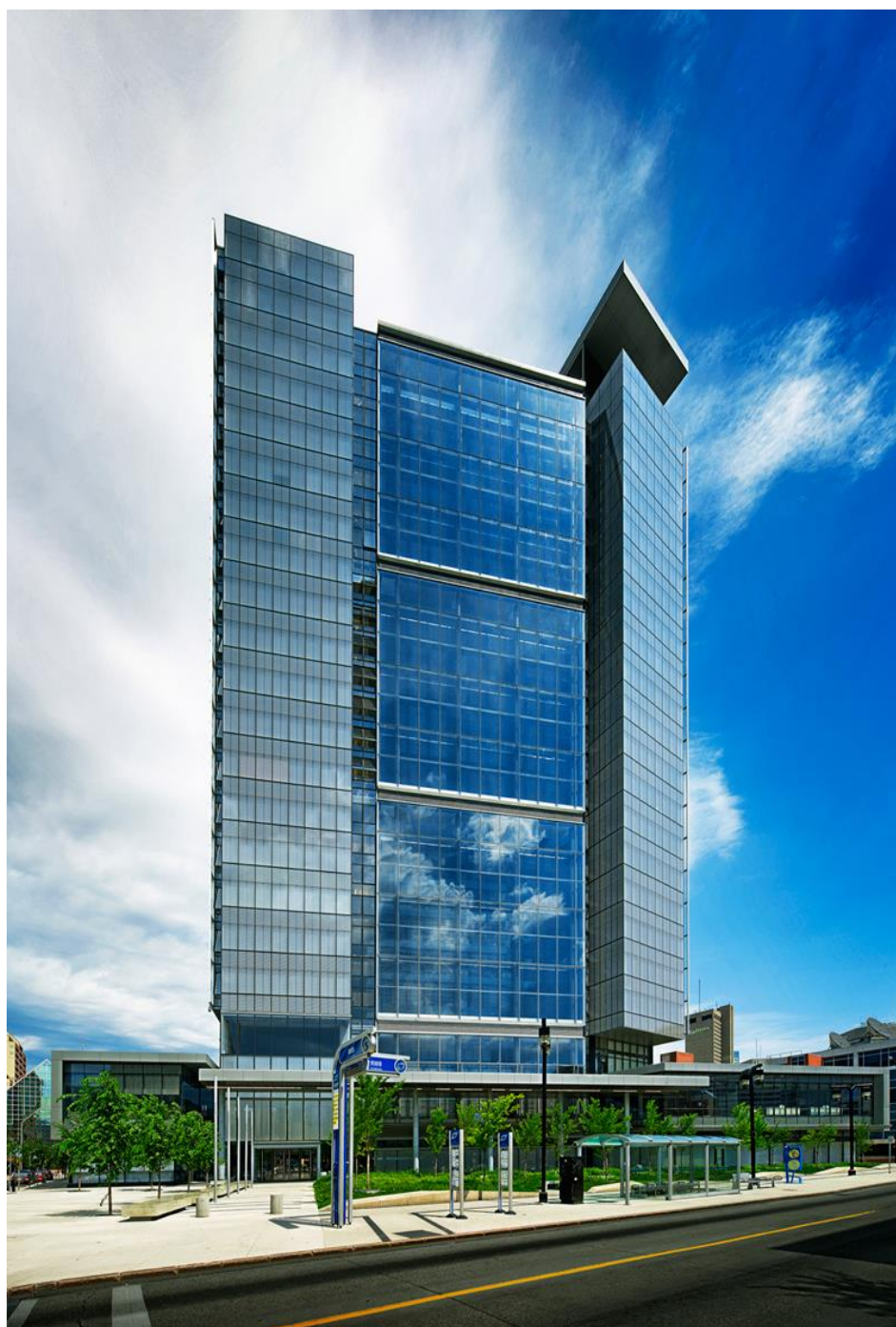
Рисунок 3 – Офисный центр Manitoba Hydro Place
