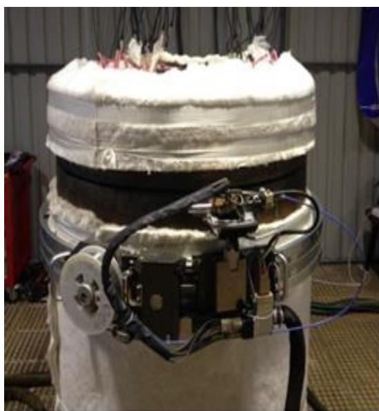
Рисунок 18 (а) – Односторонняя сварка с применением автомата фирмы «Полисуд»
