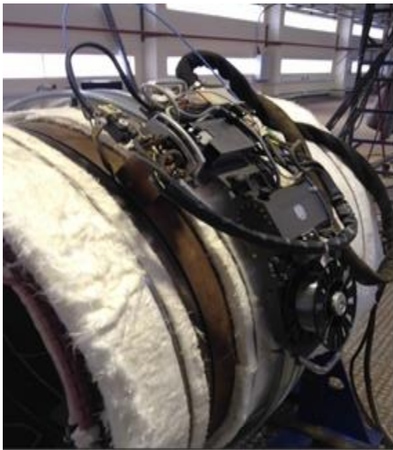
Рисунок 18 (в) – Двухсторонняя «классическая» сварка с применением автомата фирмы «Полисуд»
