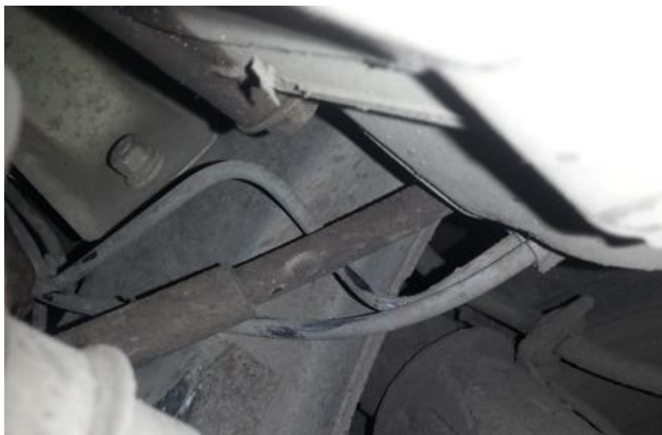
Рисунок 24 – Протираем тормозных трубок об тросик привода сцепления
