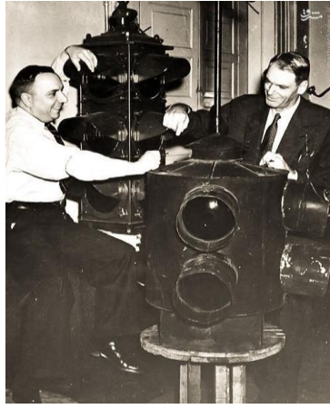
Рисунок 4 – Первый электрический светофор
