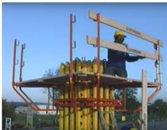
Рисунок 6 – Устройство подмостей
