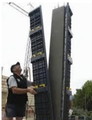
Рисунок 8 – Распалубливание колонны
