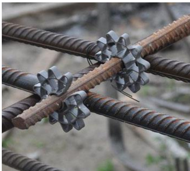
Рисунок 4 – Фиксаторы защитного слоя
