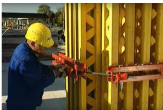
Рисунок 5 – Соединение частей опалубки тяжем
