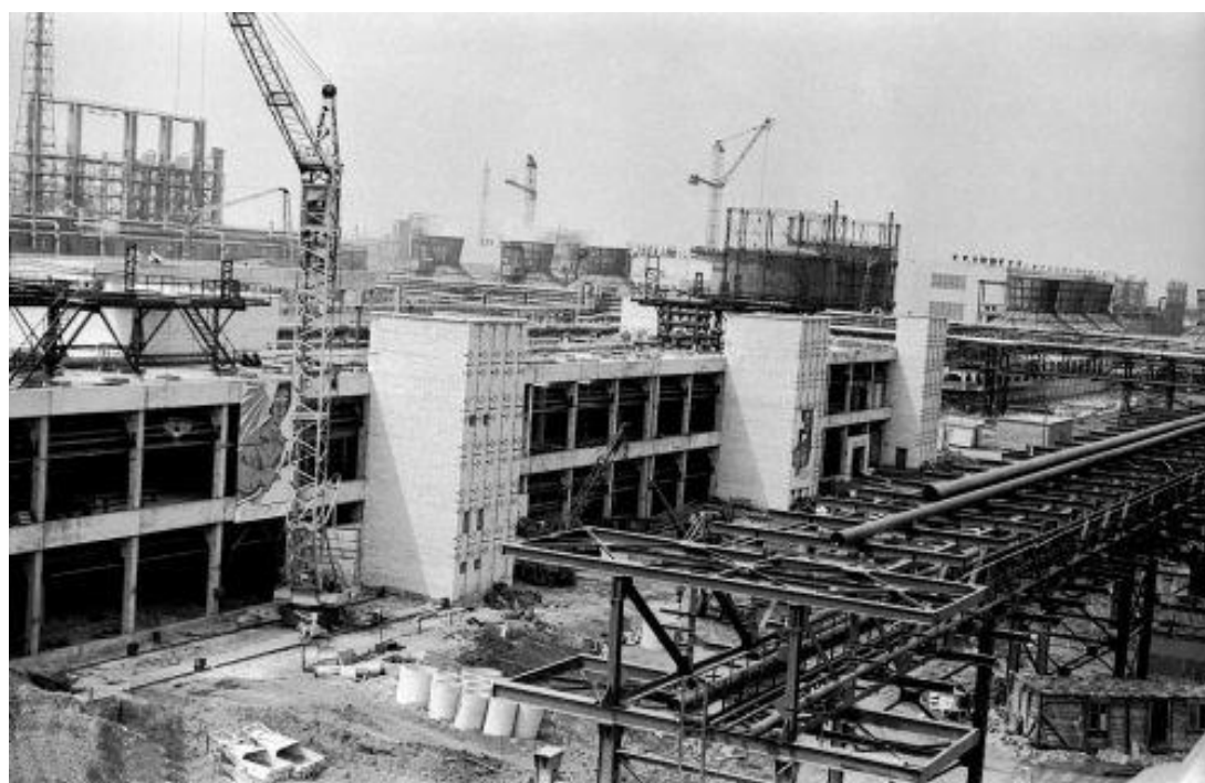
Рисунок Е.6 – КАТЗ, строительство капролактама, 1-ая очередь (1972-1973гг.)
