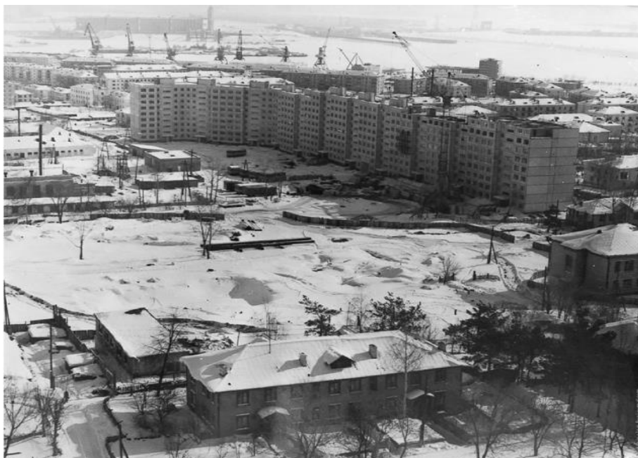
Рисунок Е.11 – Строительство девятиэтажного дом в 1970-е, по адресу Матросова 11
