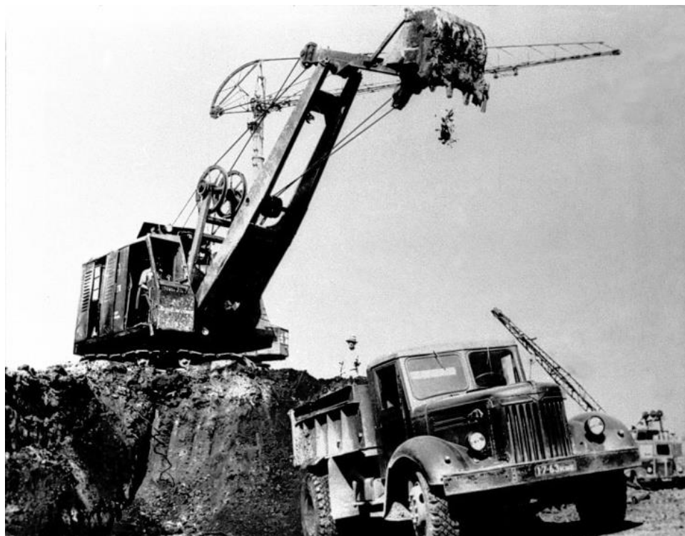
Рисунок Е.1 – Первый ковш земли, поднятый на стройплощадке завода
