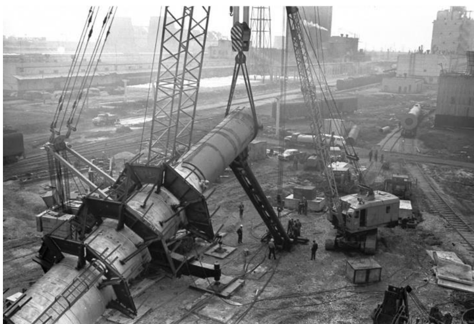
Рисунок Е.2 – Сборка оборудования крупнотоннажного агрегата аммиака 1964-1965 года (цех № 11)
