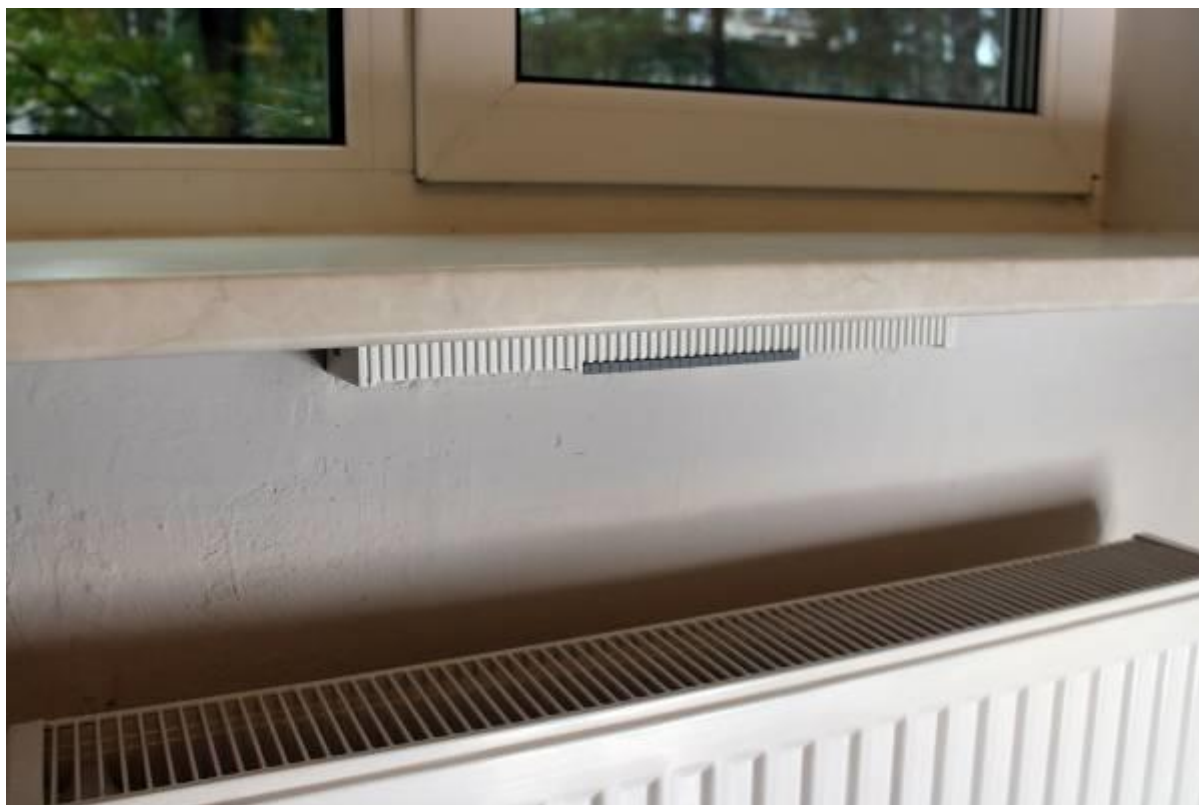
Рисунок 17 – Работа клапана Norvind City
