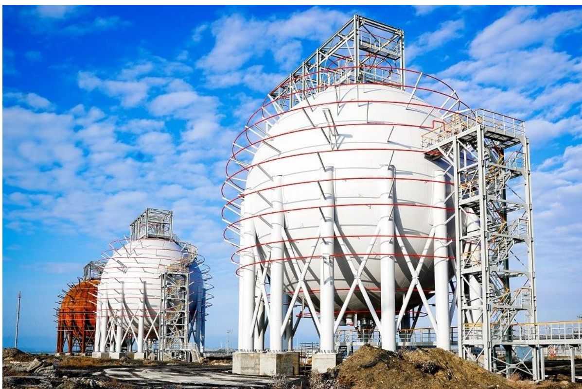
Рисунок 1 – Шаровые резервуары объёмом 5000 кубических метра
