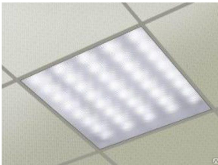
Рисунок 18 – Пример монтажа светодиодного светильника типа OFLED SL 66 в нише навесного потолка
