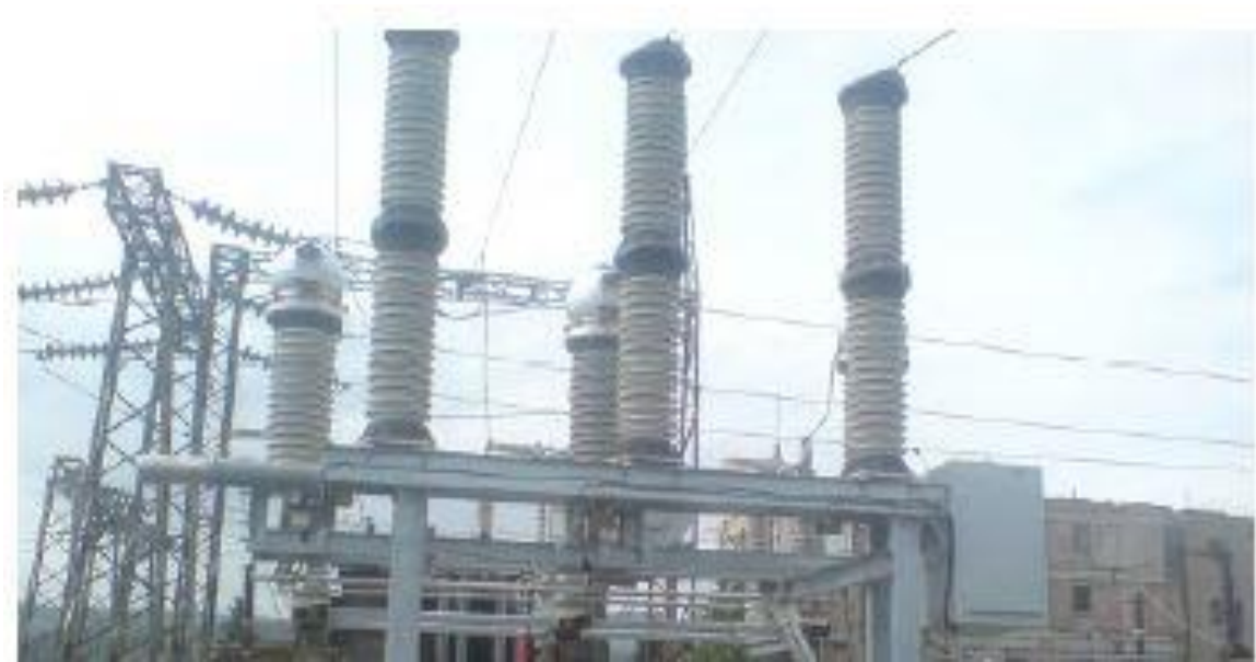
Рисунок 5 – Внешний вид элегазового колонкового выключателя типа ВГТ-УЭТМ-110-40/3150У1
