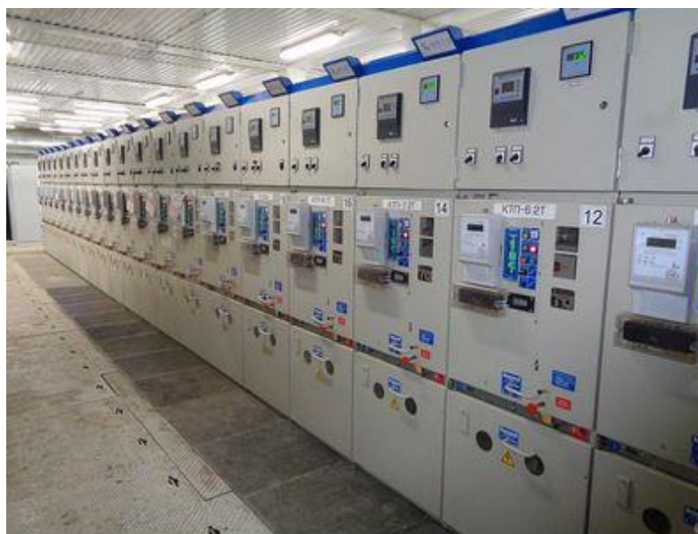
Рисунок 9 – Внешний вид секции ячеек 6 кВ серии КРУ-СЭЩ-70
