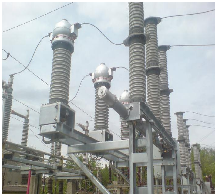
Рисунок 7 – Внешний вид измерительного трансформатора тока типа ТРГ-УЭТМ-110 УХЛ1
