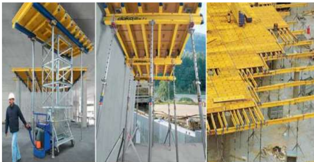
Рисунок 13 – Устройство опалубки Dokaflex
