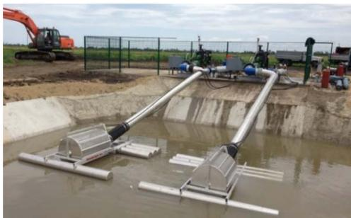
Рис. 2. Пример плавучих водоприемных оголовков из нержавеющей стали
