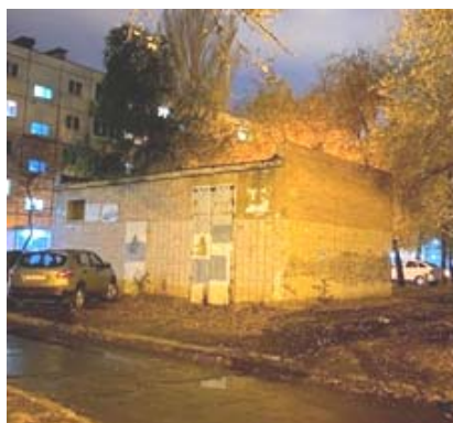
Рис. 1. Трансформаторная подстанция до экодизайна
