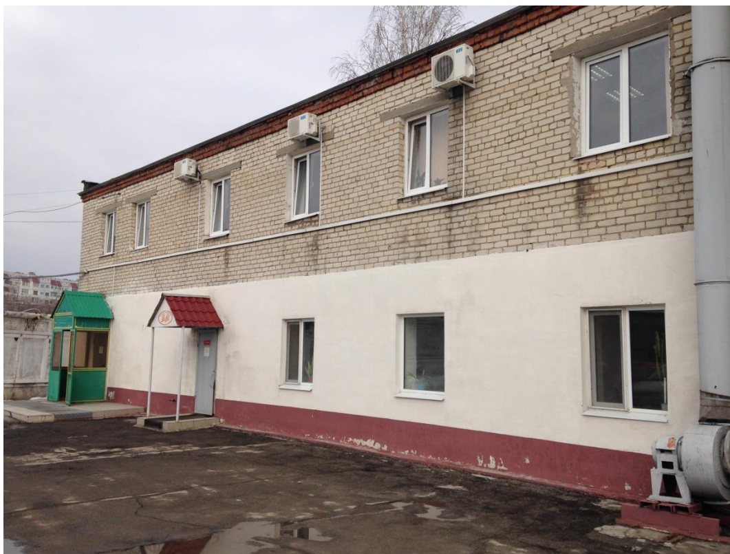
Рисунок 2 - Здание АБК (вид южной стороны )
