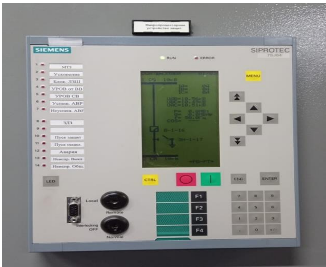
Рисунок 9 - МП устройство SIPROTEC CB 6 кВ
