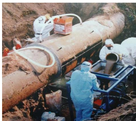
Рисунок 9 – Ремонтная муфта П1 для ремонта магистрального нефтепровода с заполнением композитным компанаудом
