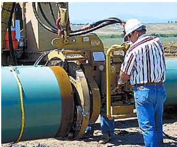
Рисунок 7 – Подготовка кромок труб с использованием станка PFM 3456
