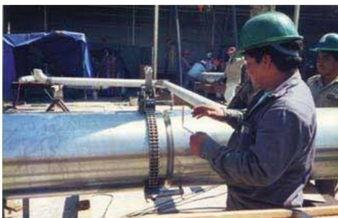
Рисунок 14 – Работа с универсальным цепным центратором
