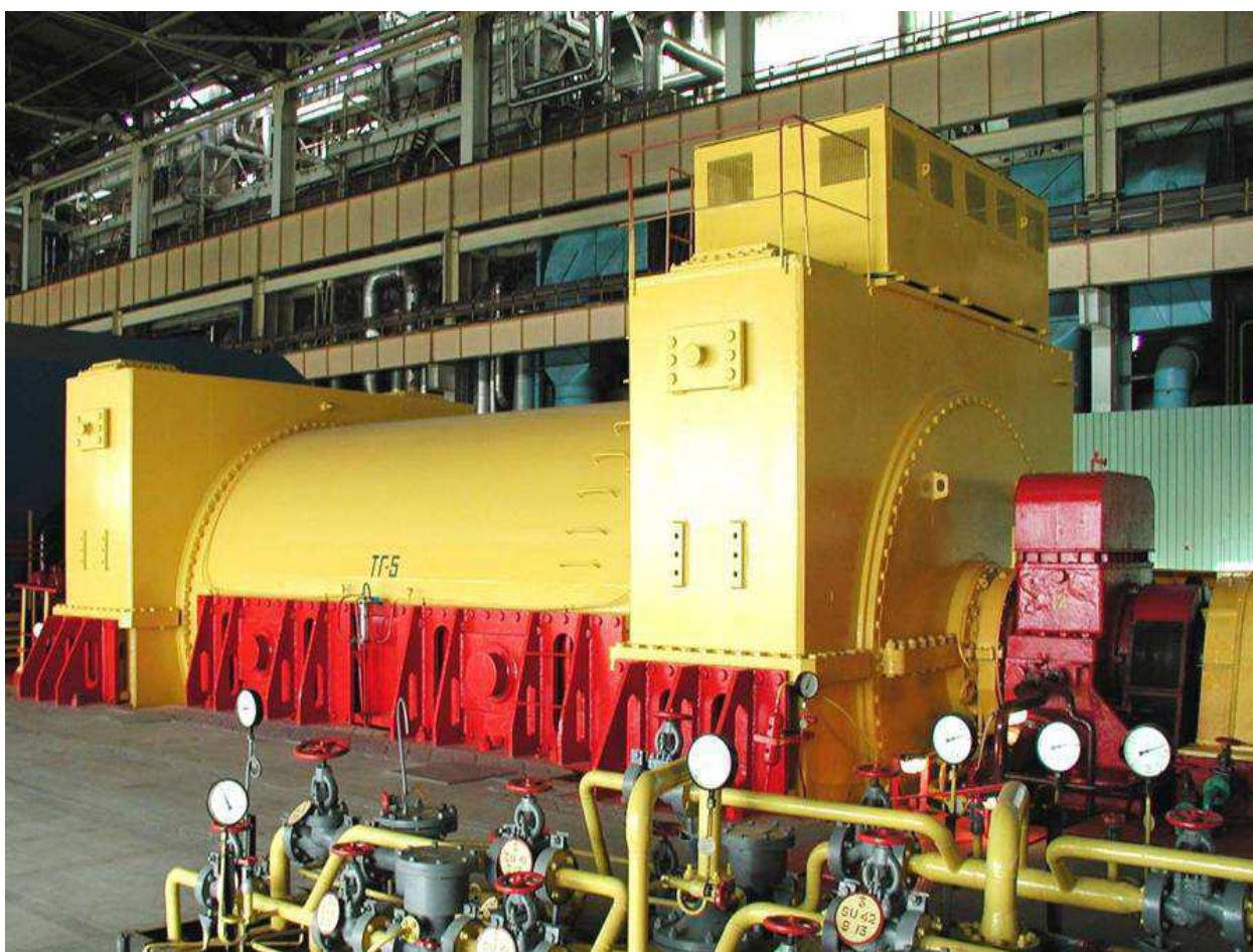
Рисунок 4 – Турбогенератор ТВВ-1000-4
