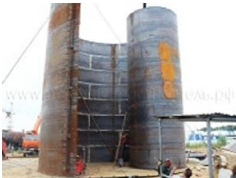
Рисунок 2 - Установка готового рулонного полотнища
