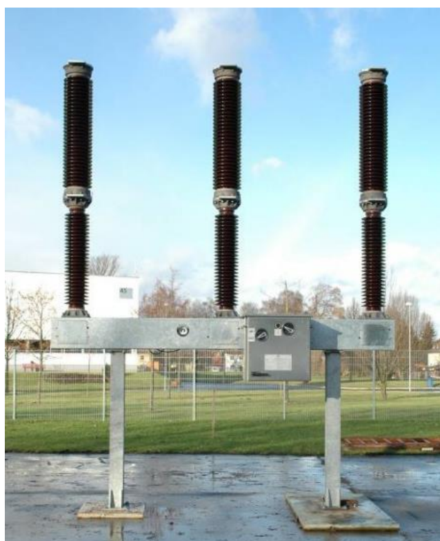
Рисунок 3 – Элегазовые выключатели типа GL
