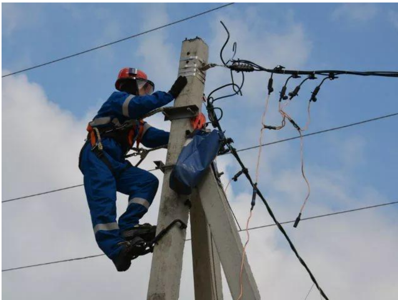
Рисунок 3 – Замена на СИП проводов ВЛ согласно [21]
