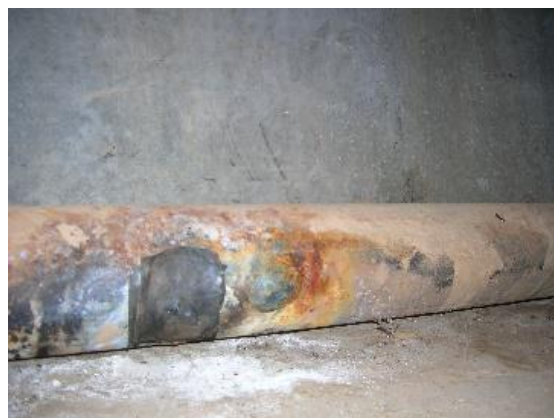
Рисунок 16 – Наружное состояние демонтированной магистрали
