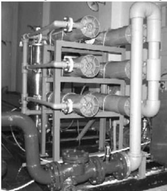
Рисунок 38 – Установка для удаления растворенного O_2 производительностью 360 м 3 /ч, состоящая из 8 параллельных цепочек по 3 модуля типа 10×28. Обеспечивает остаточное содержание O_2 менее 1 мкг/л при исходном содержании 8,9 мкг/л. Температура 24°С
