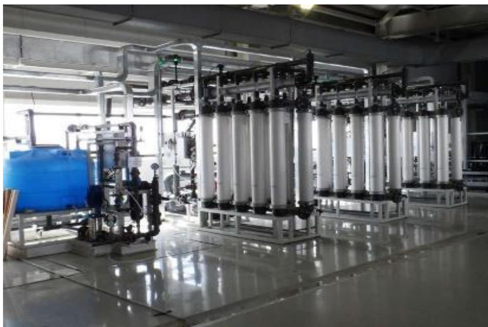
Рисунок 36 – Вертикально установленные мембранные модули
