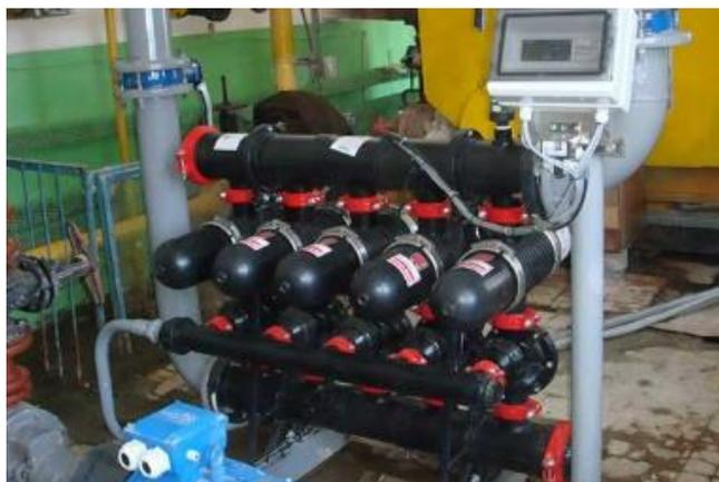
Рисунок 42 – Дисковый механический фильтр
