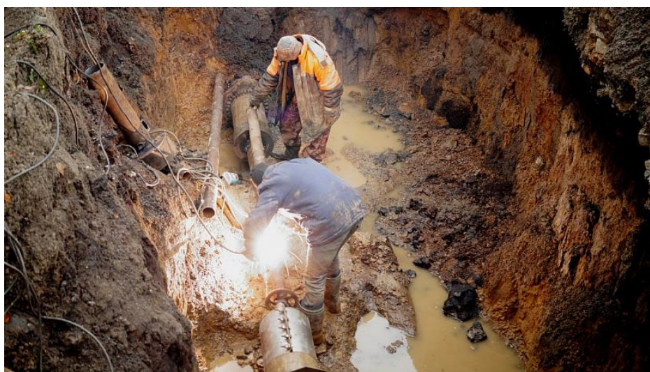
Рисунок 7 – Ликвидация аварий на водоводе
