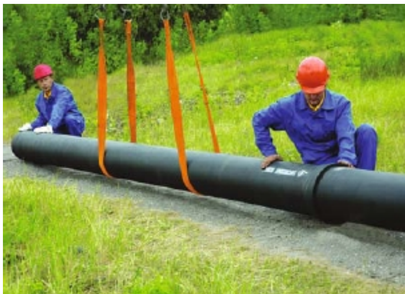
Рисунок 14 – Монтаж магистрали водовода
