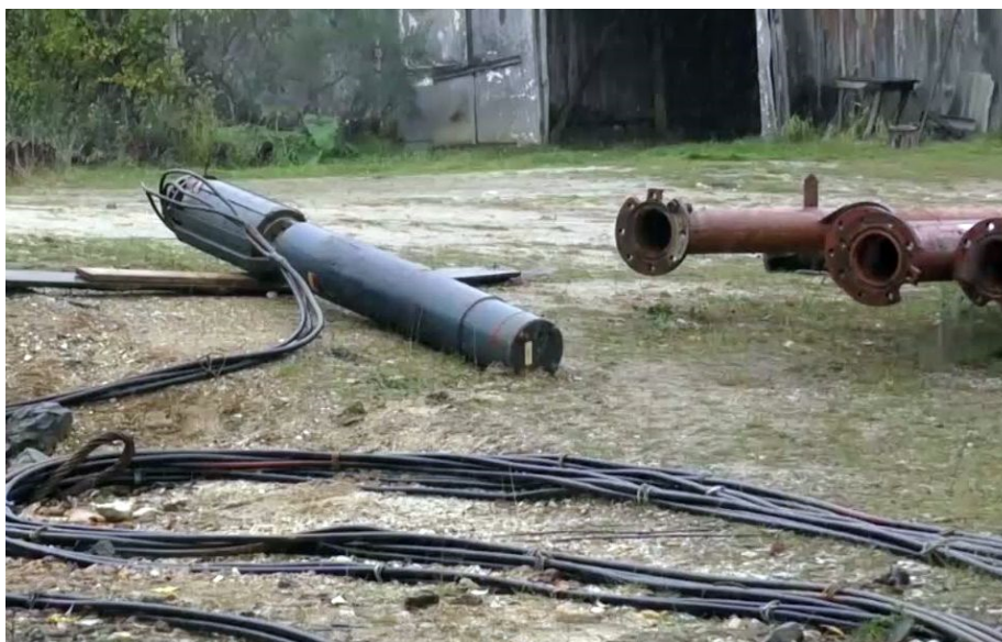
Рисунок 5 – Замена насоса на Черемшанском месторождении
