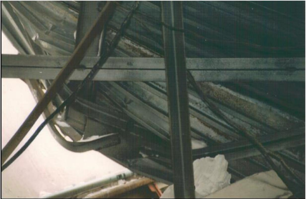
Рисунок 5 – Характерные повреждения металлических конструкций после обрушения
