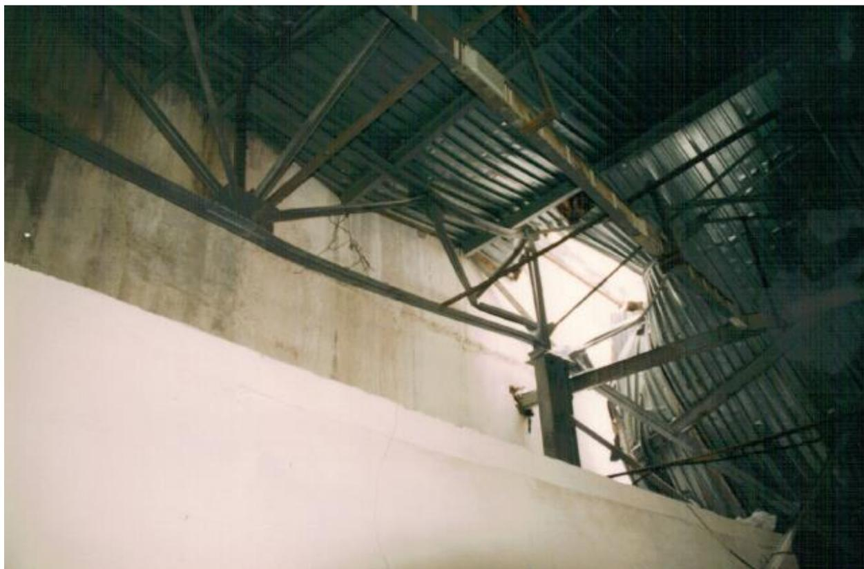
Рисунок 4 – Обрушение пролета ОАО «Пензхиммаш»
