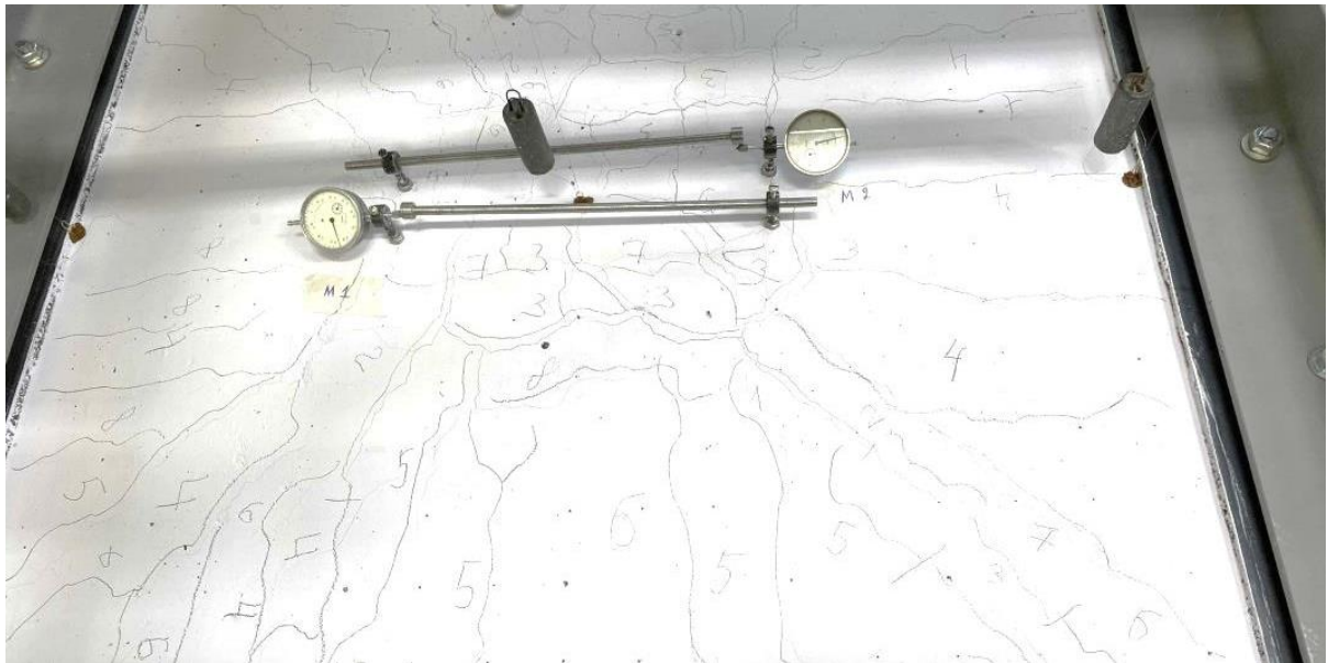
Рисунок 39 – Трещины испытанной модели железобетонной плиты со сферическими пустотообразователями
