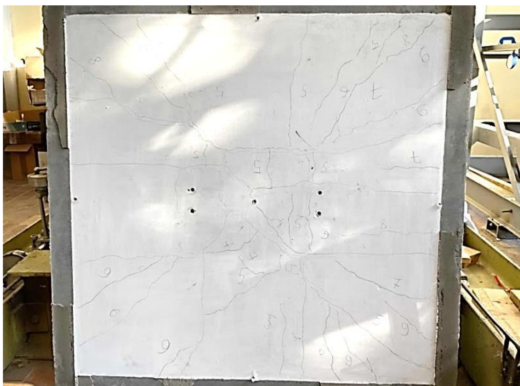
Рисунок 38 – Трещины испытанной модели полнотелой железобетонной плиты
