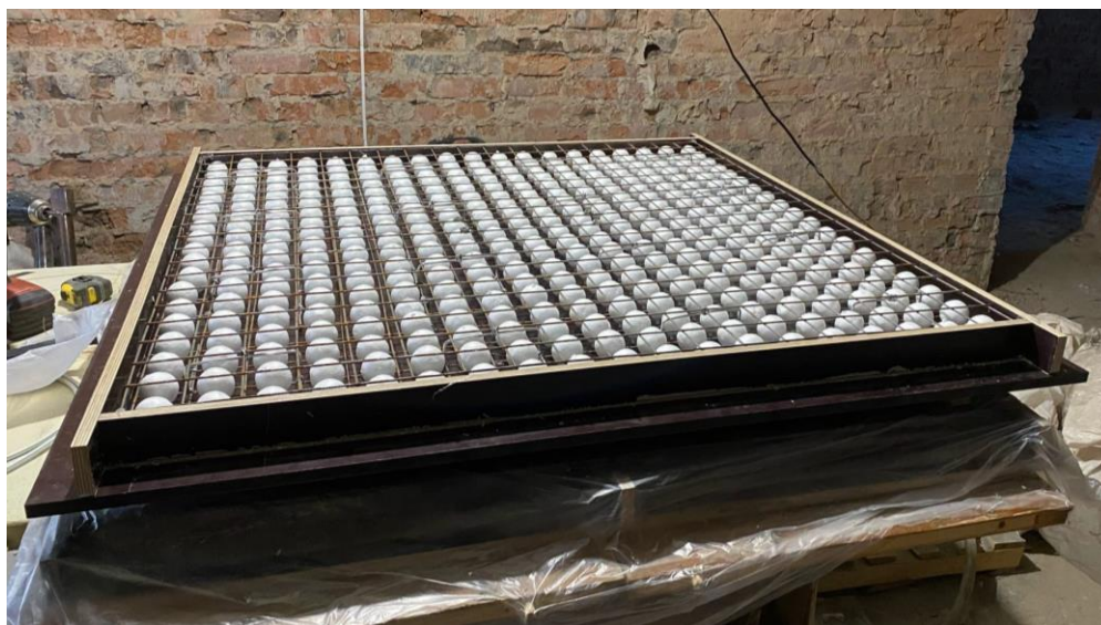
Рисунок 16 – Установка пустотообразователей в форму для модели железобетонной плиты со сферическими пустотообразователями
