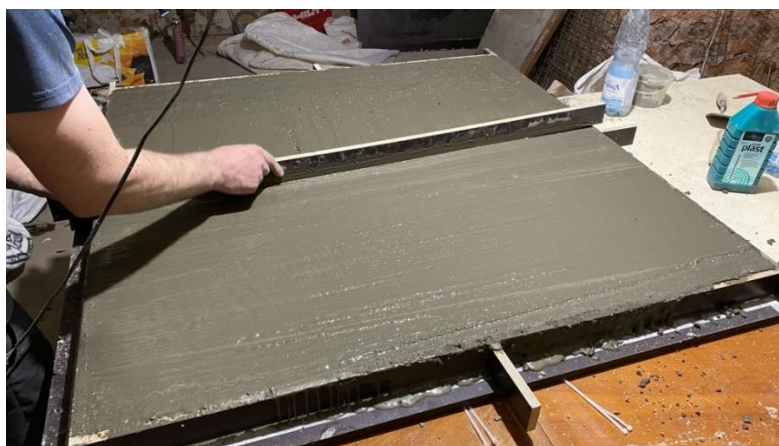
Рисунок 18 – Выравнивание поверхности бетонной смеси в форме (на фотографии показана 1 модель плиты)
