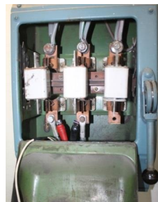
Рисунок 23 – Подключение датчика первичного напряжения со стороны первичной обмотки трансформатора контактной машины в силовом шкафу
