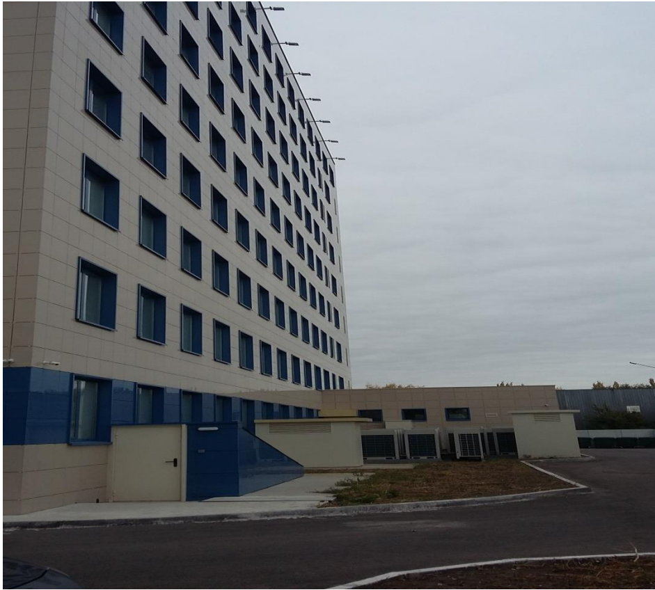
Рисунок 3 - Вид с восточной стороны
