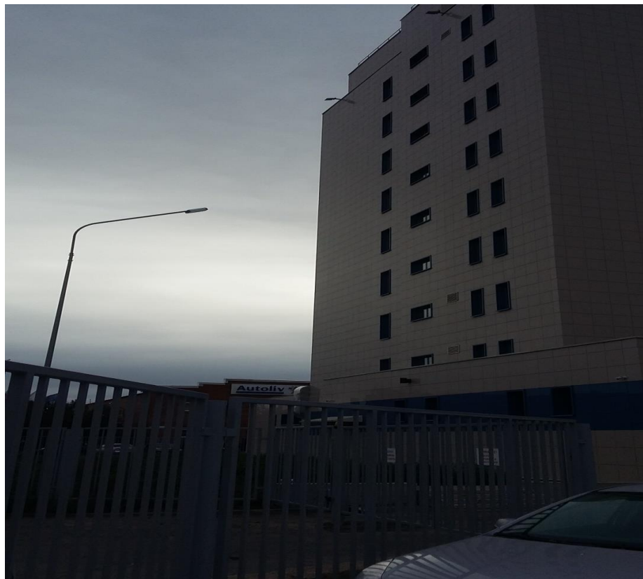
Рисунок 4 - Вид с северной стороны
