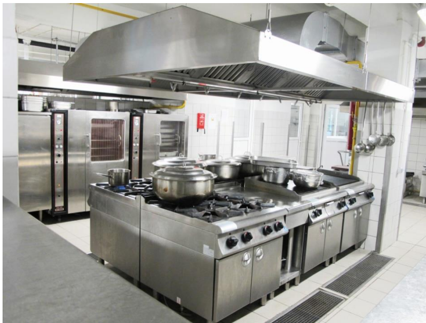
Рисунок 5 – Пример устройства вентиляционных зонтов над кухонным оборудованием
