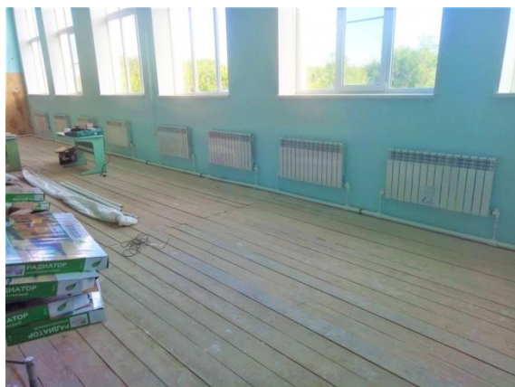
Рисунок 4 – Пример горизонтальной системы отопления в спортивных залах
