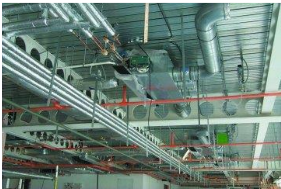
Рисунок 1 – Система вентиляции ТЦ
