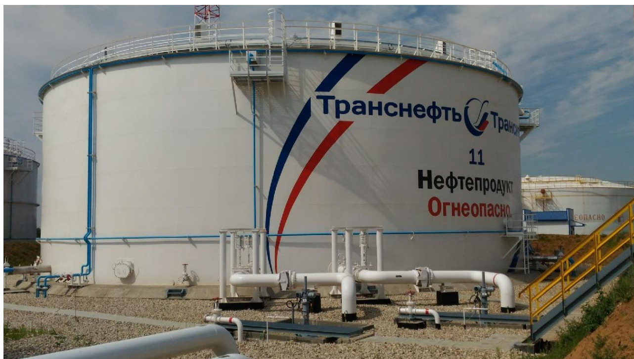
Рисунок 1 - Общий вид вертикального резервуара
