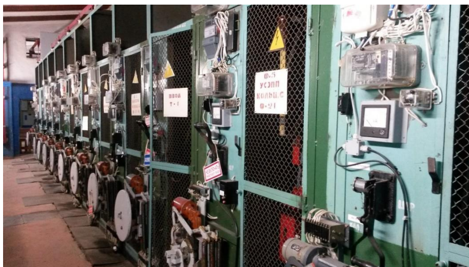
Рисунок 1 – Ячейки ЗРУ-6кВ
