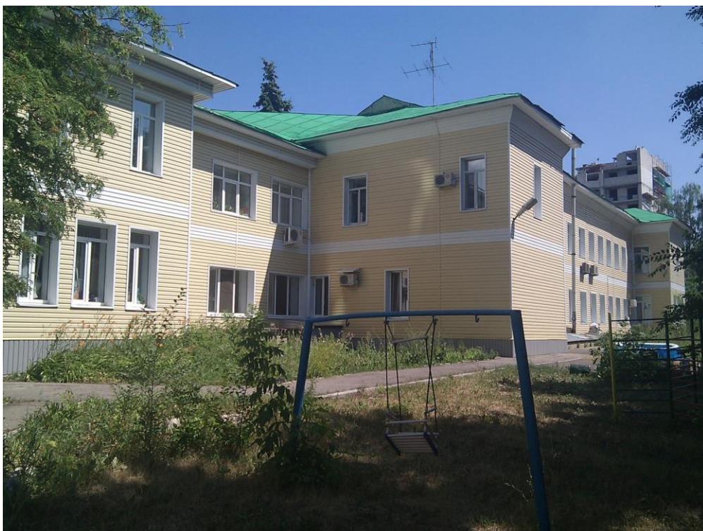
Рисунок 1 – Основной вид здания «Дом ребенка «Солнышко»
