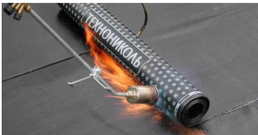
Рисунок 3.2 – Технология наплавления рулона
