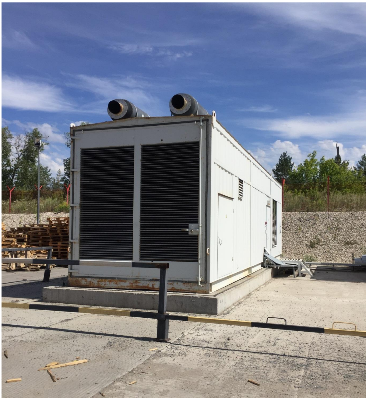
Рисунок 4 - Стационарный ДГУ
