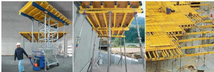
Рисунок 3.2 – Монтаж опалубки Dokaflex
