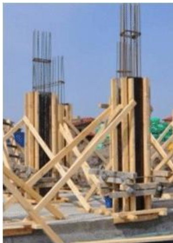
Рисунок В.2 – Армирование колонн
