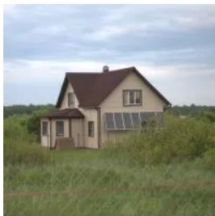
Батареи общей мощностью 1,2 КВт
