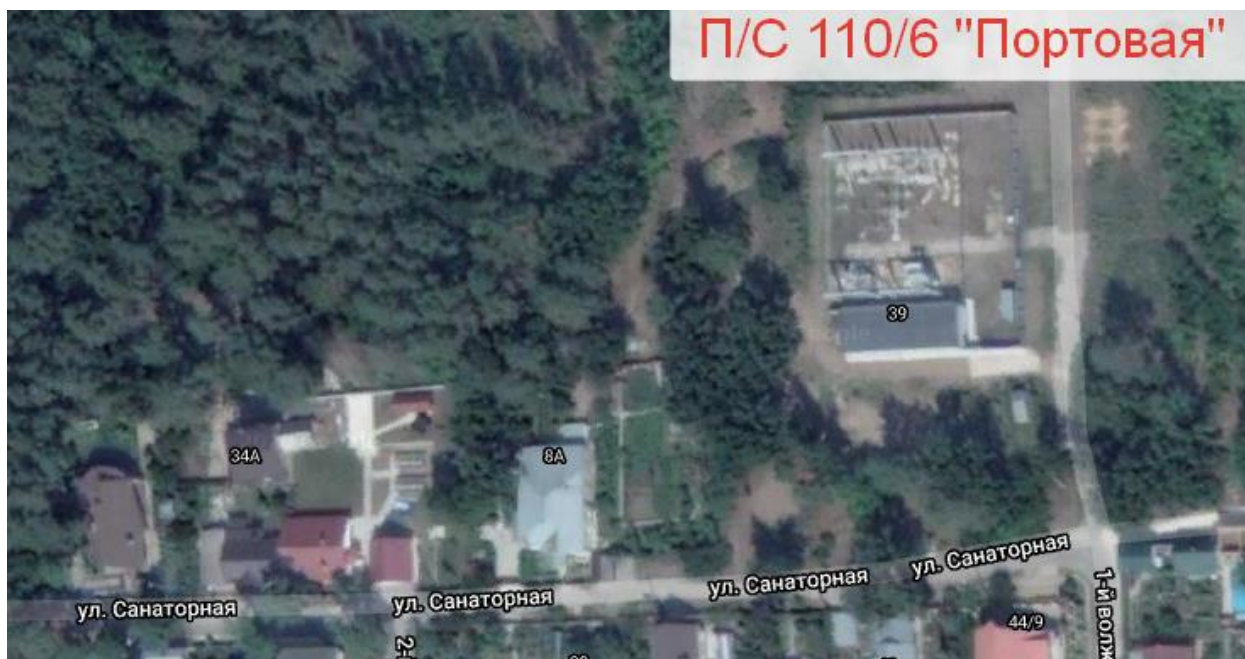
Рисунок 1 – Подстанция 110/6 «Портовая», вид со спутника
