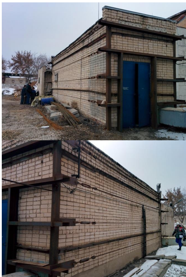
Рисунок 17 – Общий вид здания камеры баков давления
