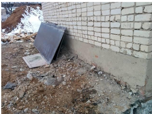
Рисунок 27 – Повреждения отмостки
