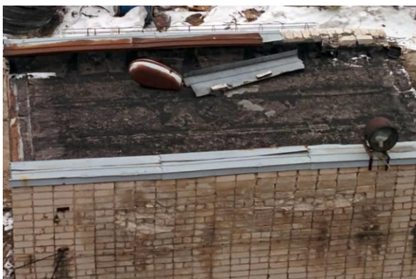
Рисунок 28 – Повреждения кровли
