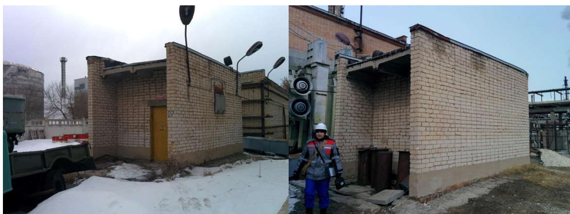
Рисунок 13 – Общий вид здания вентиляционной шахты № 1
