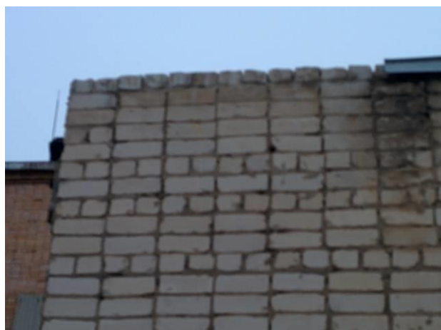
Рисунок 25 – Повреждения парапета
