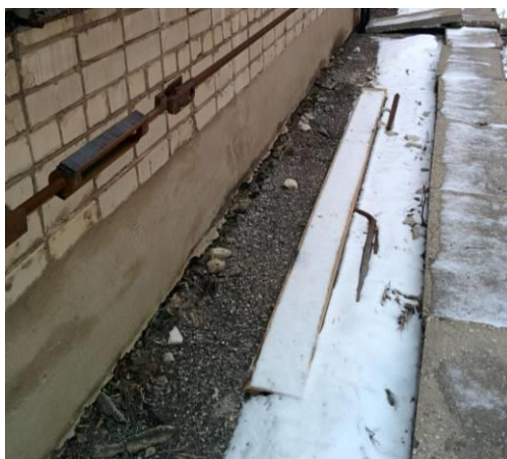
Рисунок 21 – Повреждения отмостки
