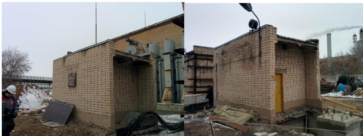
Рисунок 23 – Общий вид здания вентиляционной шахты № 2
