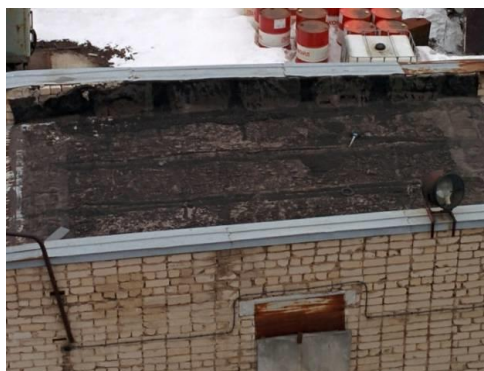
Рисунок 16 – Повреждения кровли
