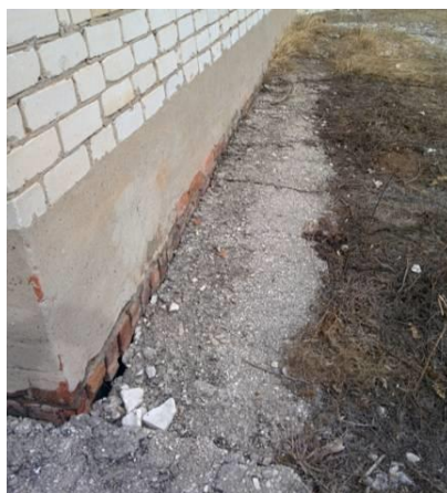
Рисунок 15 – Повреждения отмостки
