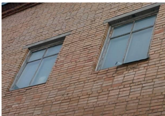
Рисунок 5 – Окна кирпичной стены на отметке +7.200 м в осях «А/11»
