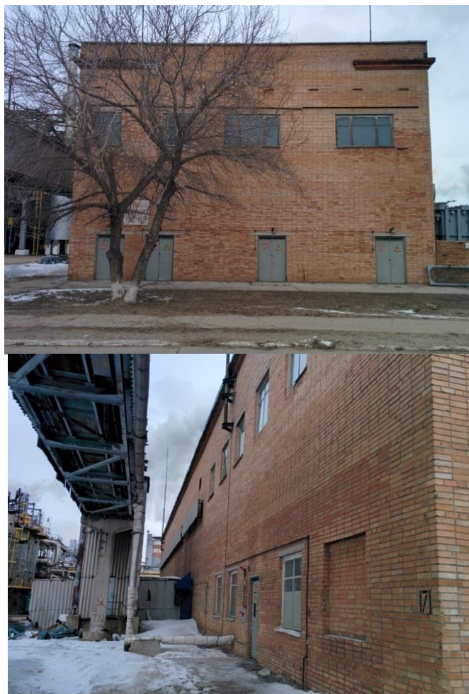
Рисунок 1 – Общий вид здания корпуса 171 «ГПП–1»
