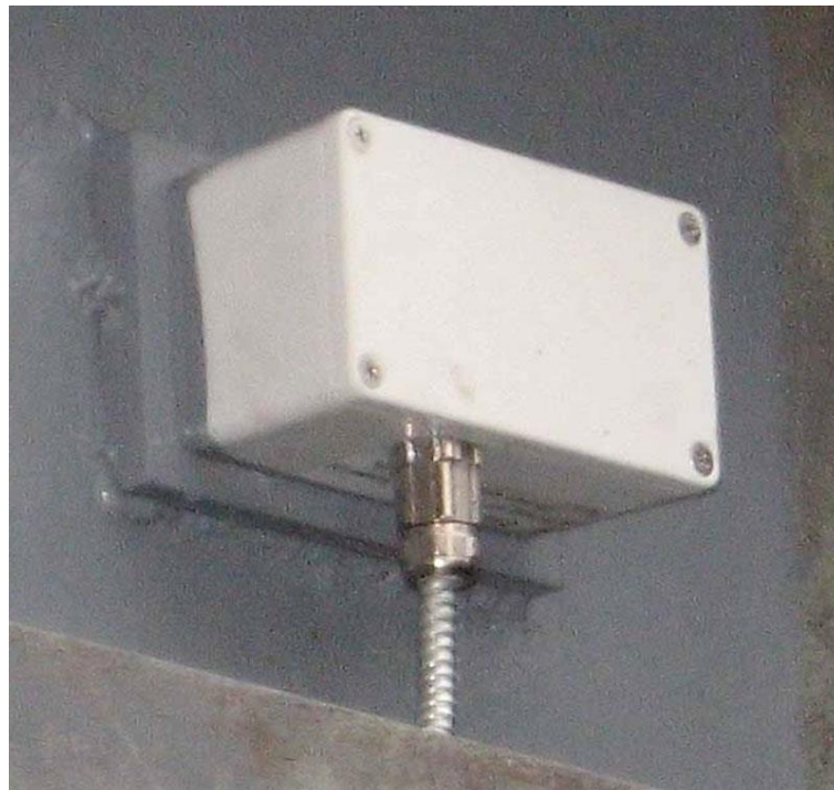
Рисунок 32 – Монтированный виброакустический датчик
